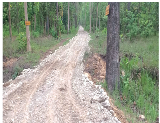
वनपथ निर्माण, बाँके रा.नि.
