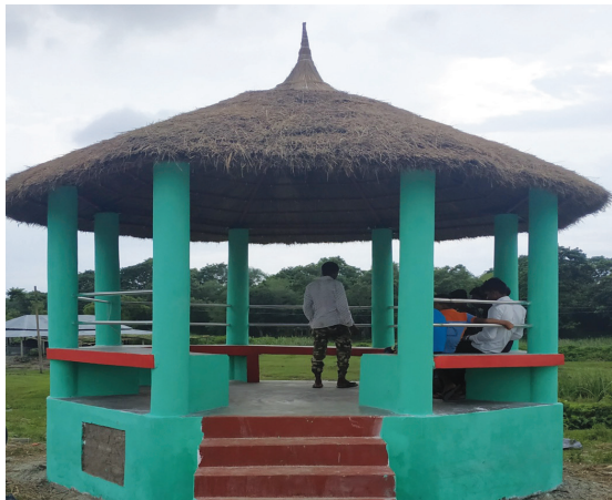
गोलघर निर्माण, कोशीटप्पू व.आ.
