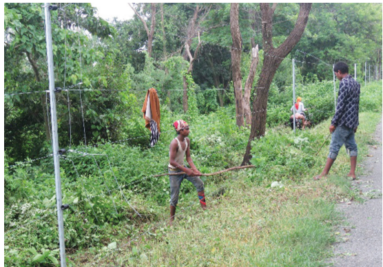
सोलार फेन्सिङ्ग निर्माण, कोशीटप्पू व.आ.
