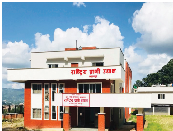
कार्यालय भवन निर्माण, राष्ट्रिय प्राणी उद्यान
