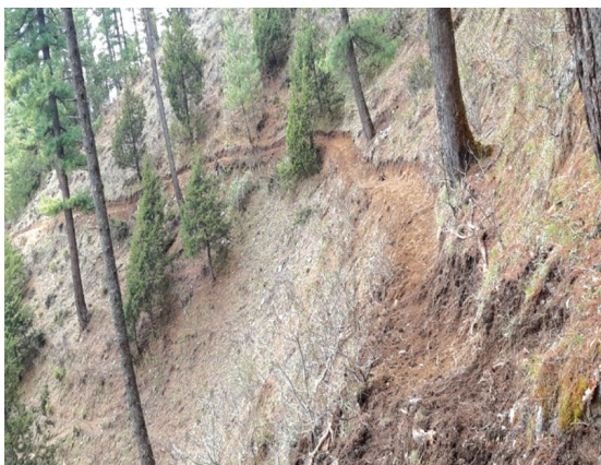
डढेलो नियन्त्रणका लागि अग्निरेखा निर्माण, ढोरपाटन शि.आ.
