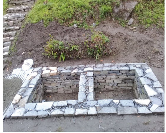
फोहोरमैला व्यवस्थापनका लागि खाडल निर्माण, मकालु रा.नि.
