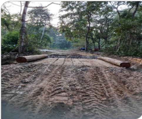
वन पथ निर्माण, चितवन रा. नि.
