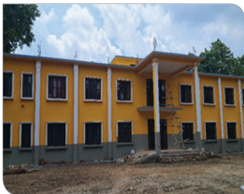
कार्यालय भवन निर्माण, शुक्लाफाँटा रा. नि.
