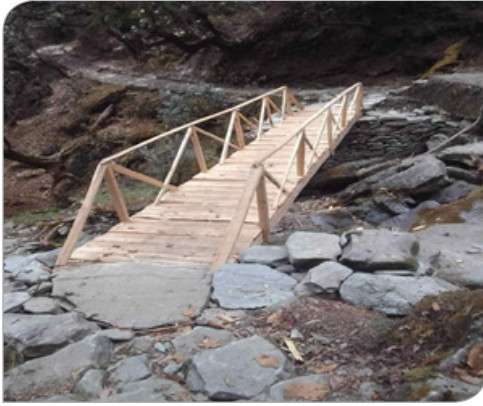
कोठे पुल निर्माण, लाङटाङ रा. नि.
