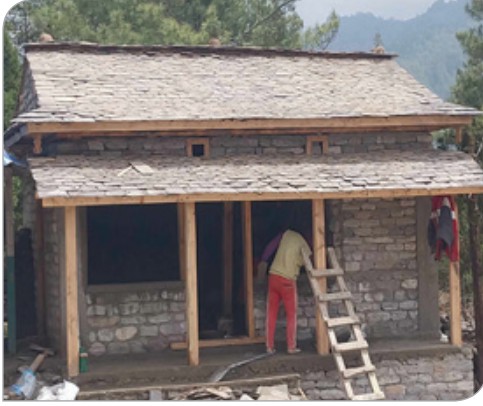
होमस्टे प्रवर्द्धनका लागि चिनो पसल निर्माण, ढोरपाटन शि. आ.
