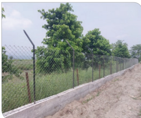
पि.सि. सि. सहितको मेषजाली निर्माण, चितवन रा. नि.
