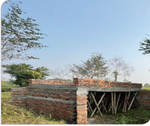
कल्वर्ट निर्माण, कोशी टप्पु व. आ.
