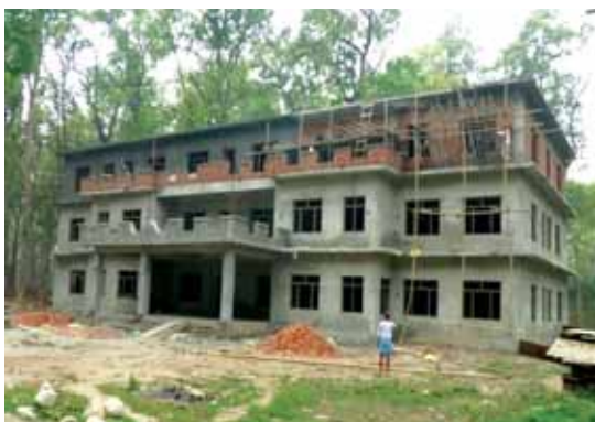
कार्यालय भवन निर्माण, चितवन रा.नि.
