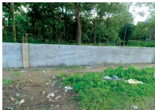
मानव-वन्यजन्तु द्वन्द्व ब्यबस्थापनको लागि आर.सी.सी. वाल निर्माण, चितवन रा.नि.
