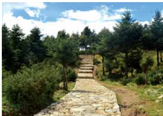
बाटो निर्माण, सगरमाथा रा.नि.
