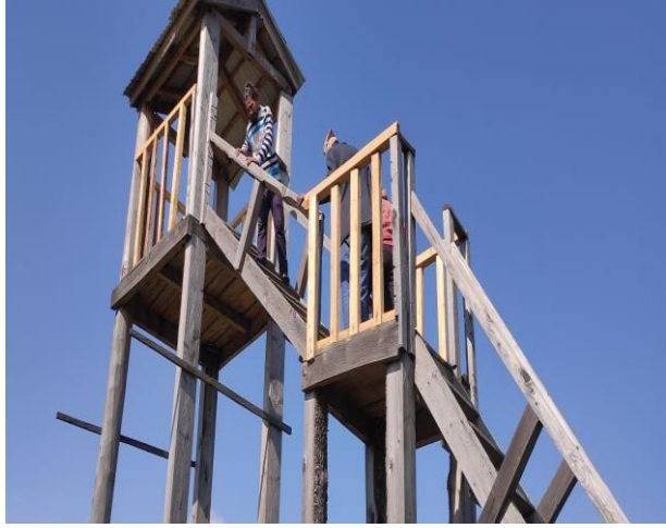
भ्यू टावर निर्माण, खप्तड रा.नि.
