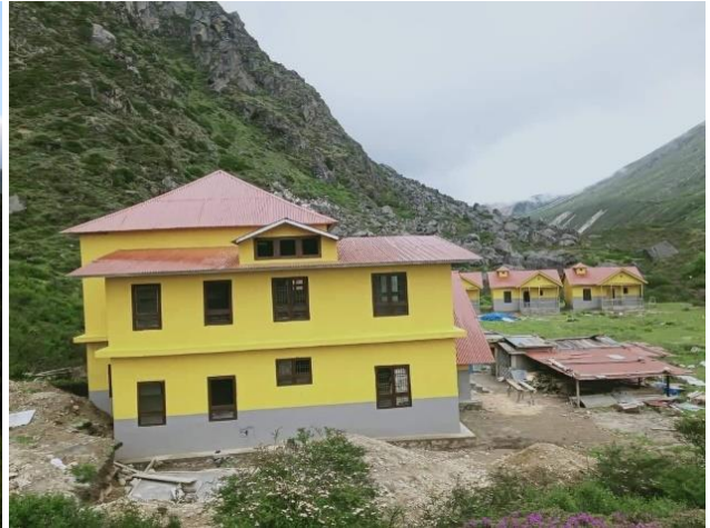
हिमालयन रिसर्च सेन्टर भवन निर्माण. कञ्चनजंघा सं.क्षे.
