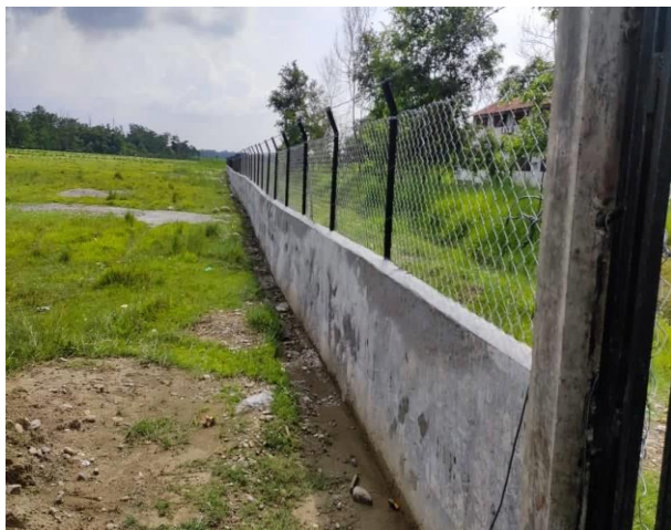
आर.सि.सि. सहितको मेषजाली निर्माण, चितवन रा.नि.
