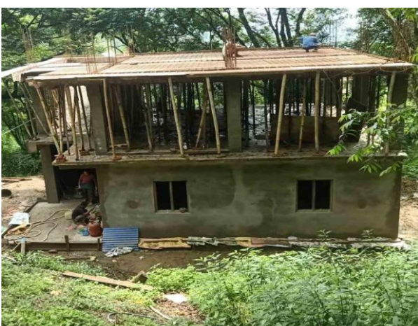
सामुदायिक भवन निर्माण, शिवपुरी नागार्जुन रा.नि.
