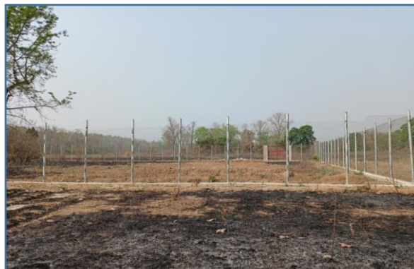
वन्यजन्तु उद्धार केन्द्र निर्माण, बाँके रा.नि.
