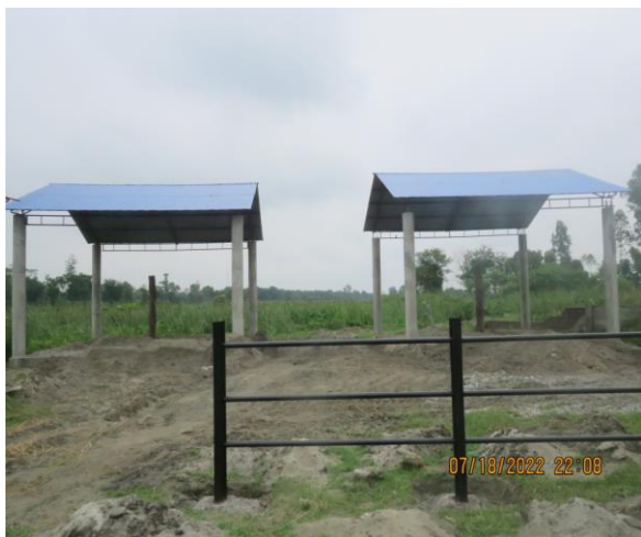
हात्तीको सेडघर निर्माण, कोशीटप्पु वन्यजन्तु आरक्ष
